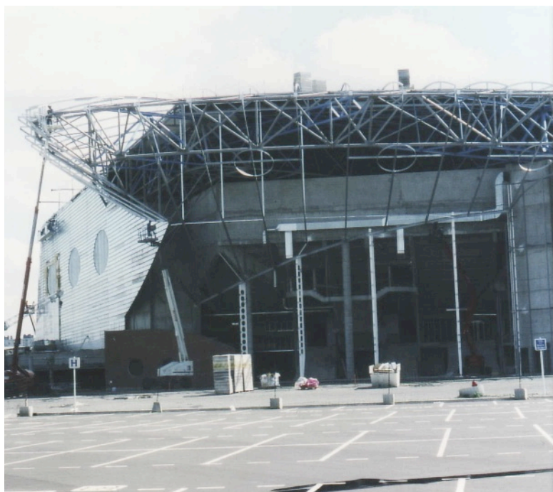
Charpente Métallique de l'aile d'avion en couverture de façade principale
