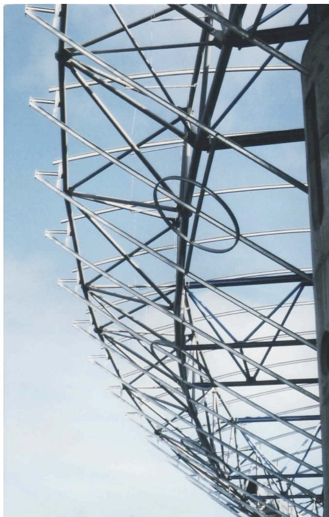
Charpente Métallique de l'aile d'avion en couverture de façade principale
